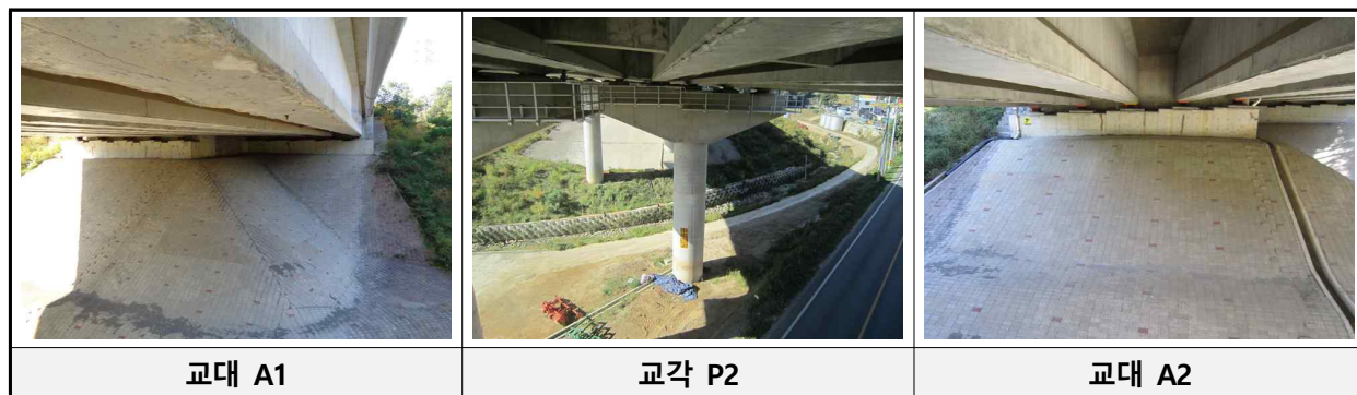
[교대 및 교각 전경]
